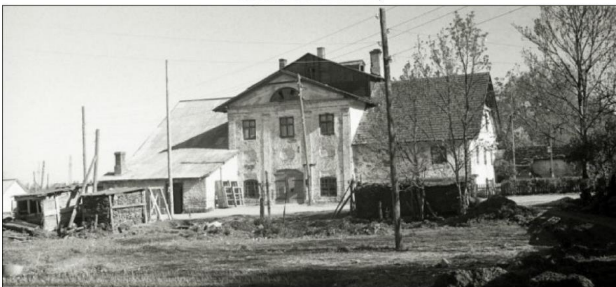
Vaade viinavabriku esifassaadile Pildi autor: Jaan Rannik
