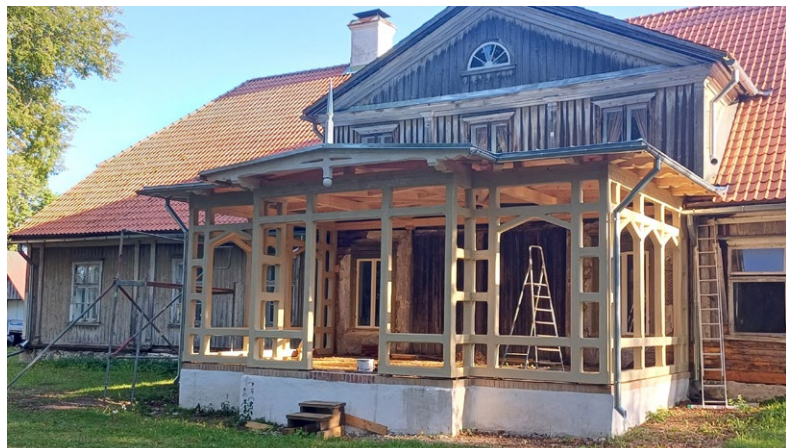
Uue-Varbla mõisa veranda restaureerimisel taastatakse algupärased dekoratiivsed detailid. Foto: erakogu
