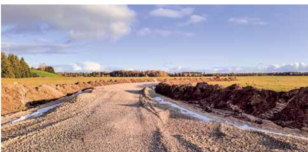
Koonga ümbersõidutee ehitustööd. Foto: Mihkel Kalmaru
